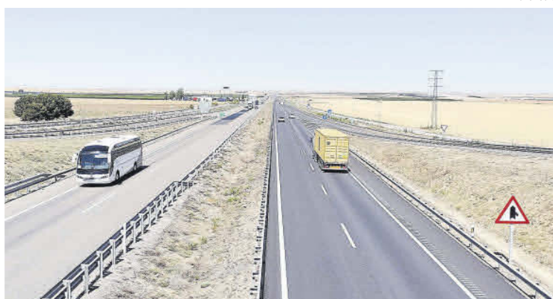
La Autovía A-2, a su paso por Calatorao.
